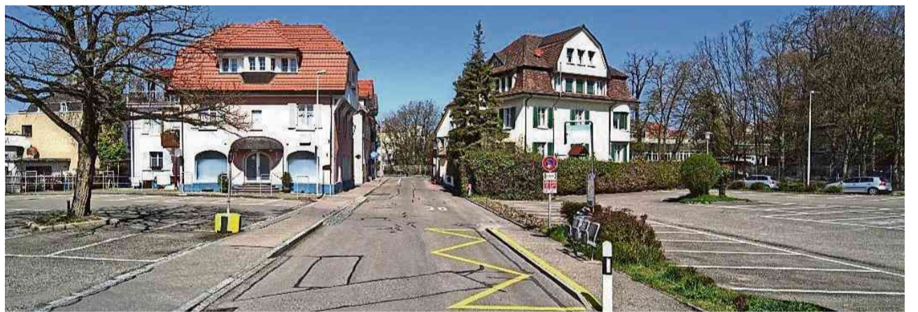
Die Arbeiten an den Bushaltestellen an der Dufourstrasse haben begonnen.
