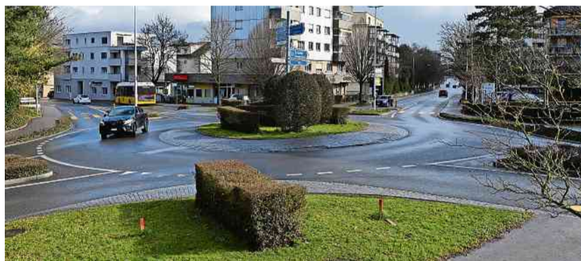
Der Rebstockkreisel wird saniert. Baustart ist am 2. März.
